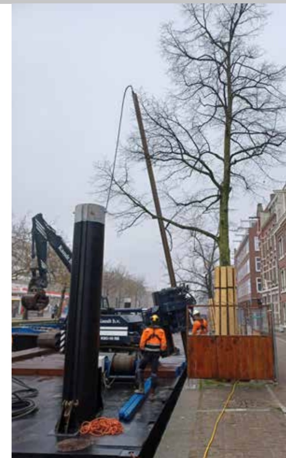
Aanbrengen van Leka-palen vanaf het water in beperkte werkruimte
